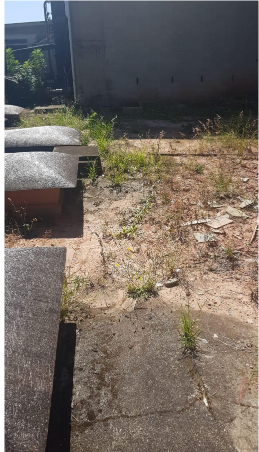
Foto 9: Laje que gera infiltração no pavimento abaixo
