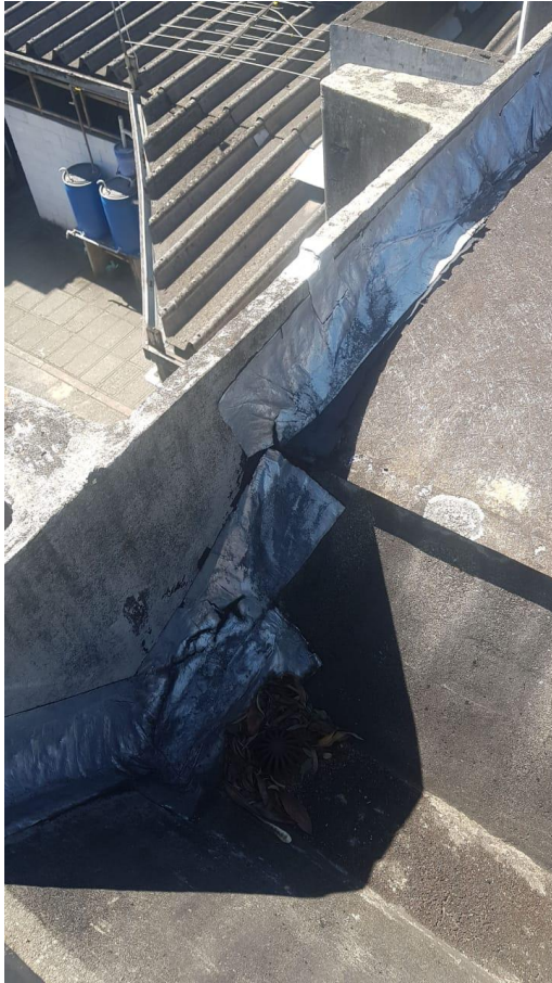
Foto 5: Cobertura do Prédio 100
