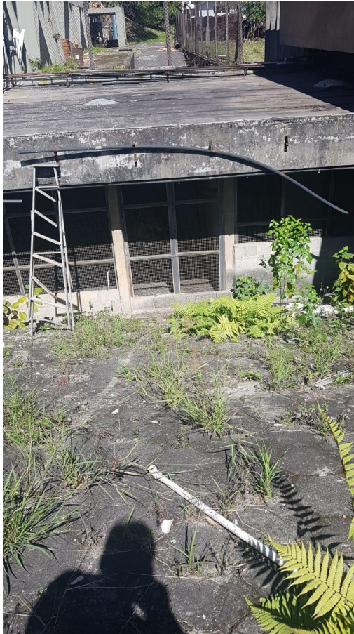
Foto 9: Laje que gera infiltração no pavimento abaixo
