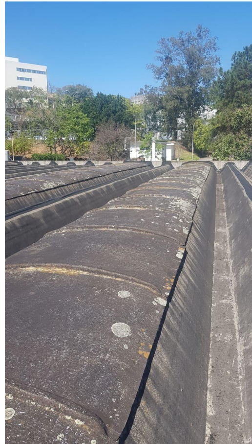
Foto 2: Cobertura do Prédio 100
