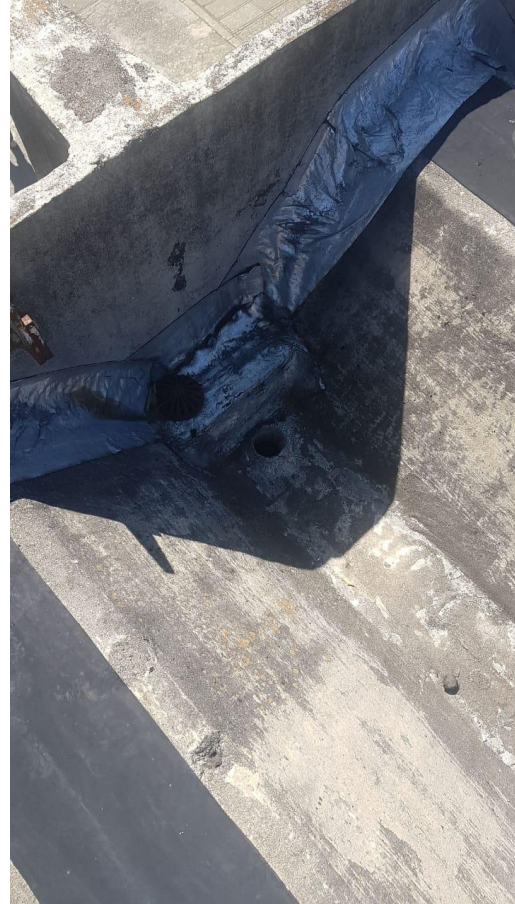
Foto 4: Cobertura do Prédio 100
