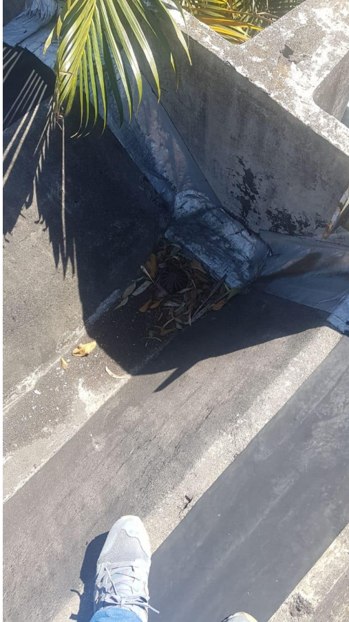
Foto 3: Cobertura do Prédio 100
