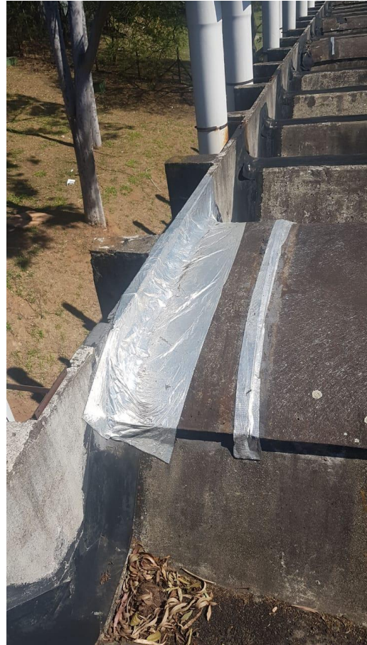
Foto 6: Cobertura do Prédio 100
