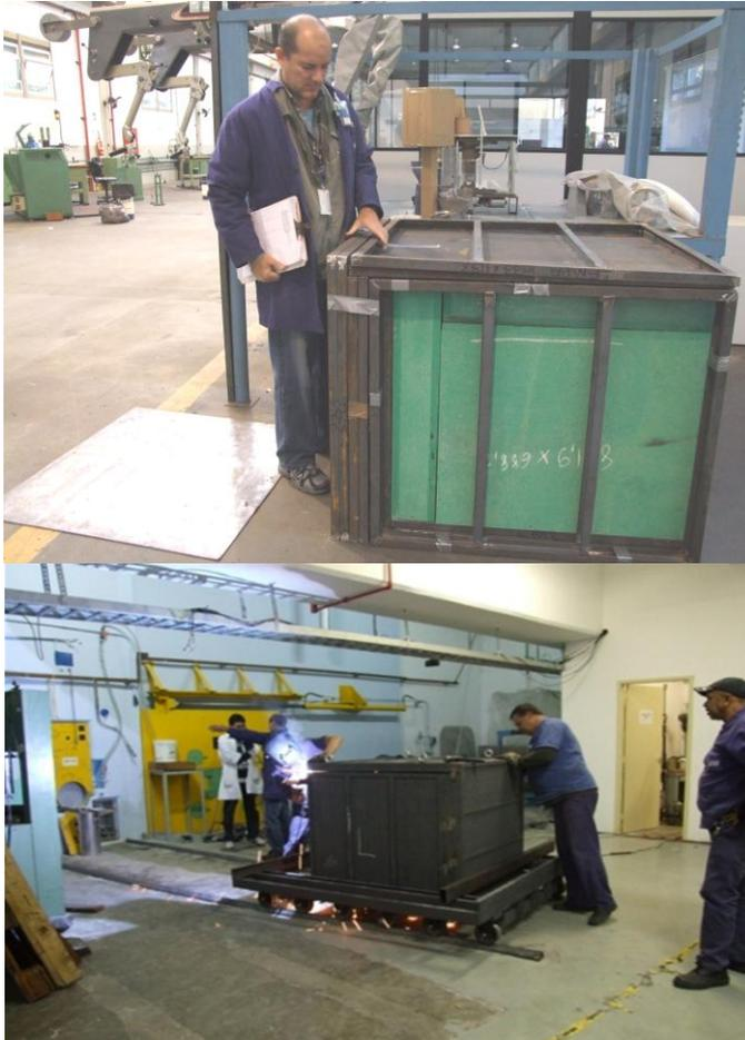
Figura 22. Montagem do *beam-catcher* nas oficinas do IPEN (cima), e a instalação da blindagem no BH nº14 do Reator Nuclear IEA-R1 (baixo).
