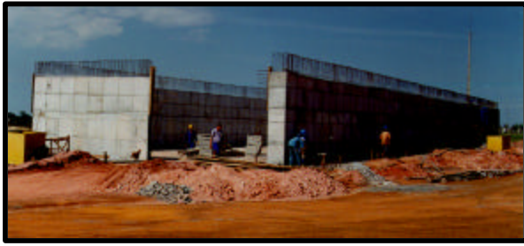
Figura 4 e 5: Etapas de construção de um dos depósitos
