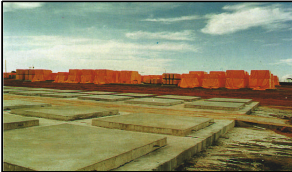
Figura 2 - Vista parcial dos rejeitos radioativos dispostos nas plataformas de concreto.
